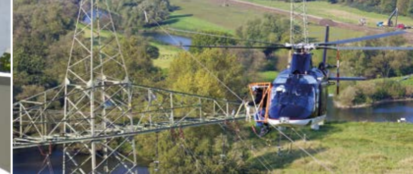
Ergebnis eines Forschungsprojektes der VSW Frankfurt. Einbau von Vogelmarkern zur Vermeidung von Vogelkollisionen an Freileitungen mittels Hubschrauber-Technik - Foto: RWE Rheinland Westfalen Netz AG.
