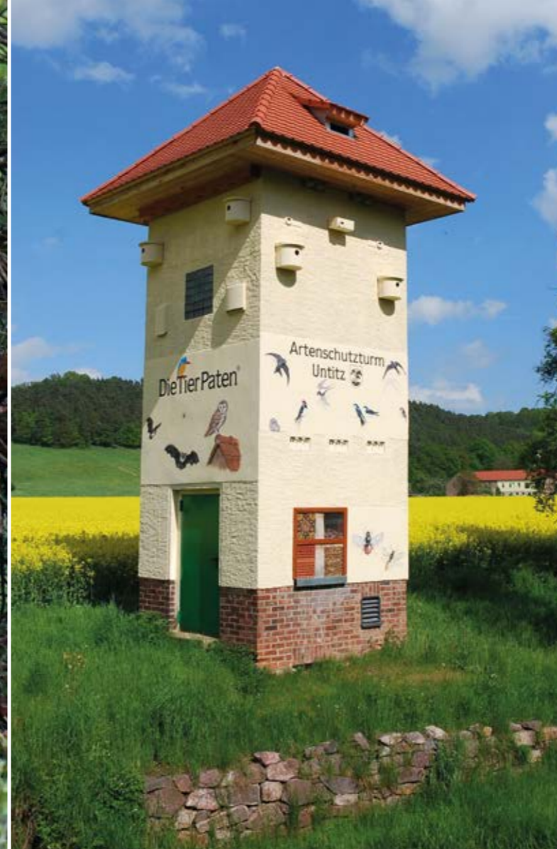
Ausgestattet mit Nisthilfen innen und außen sowie einer hübschen Gestaltung wurde aus einer ausgedienten Trafostation einer von vielen Artenschutztürmen der Stiftung Pro Artenvielfalt. - Foto und Kontakt: www.stiftung-pro-artenvielfalt.org
